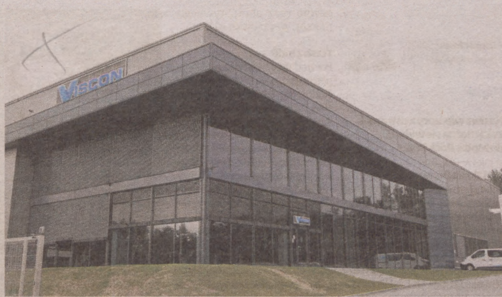
Nowa siedziba Viscon Group Poland ma powierzchnię prawie 5 tys. metrów kwadratowych
