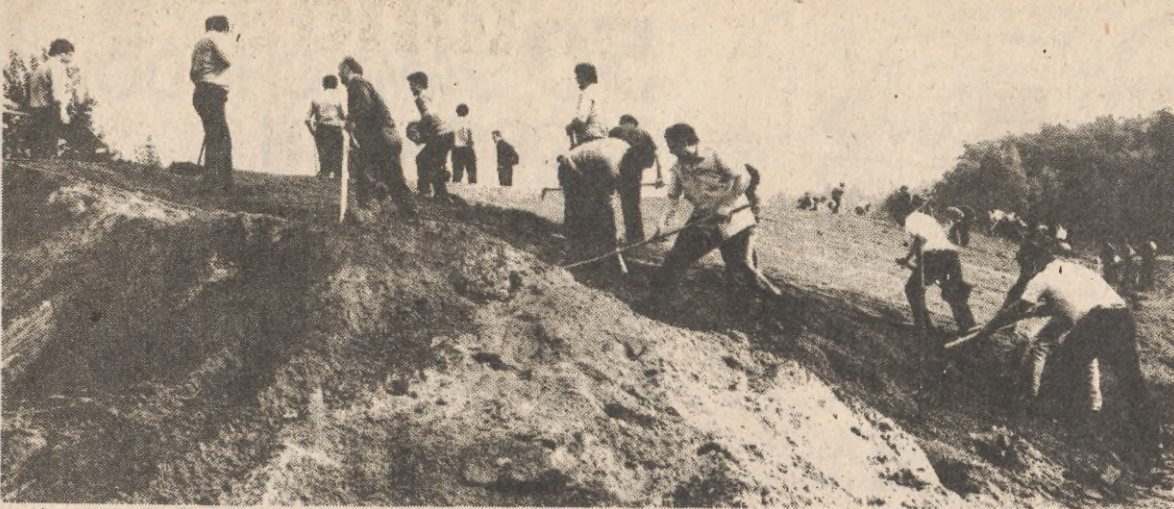
W Ustce na przyszłym stadionie.
