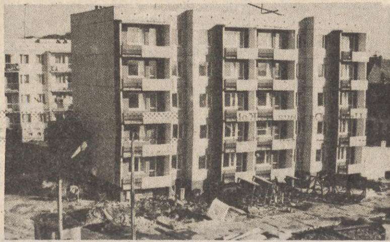
Katino. Przed kilkoma dniami oddano tu do użytku nowy budynek o 20 mieszkańach. Główny wykonawca — Kombinat Budowlany w Kolobrzegu — dobrze wywiązał się ze swego zadania przekazując obiekty w planowanym terminie. Fot. Jerzy Patan
