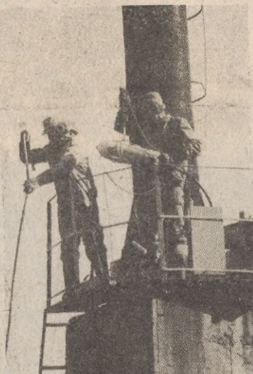
Ośrodek Badań i Kontroli Ochrony Środowiska w Koszalinie prowadzi okresowe badania emisji pyłów. Po pobraniu próbek laboratorium określa stopy skażenia powietrza. (kar) Na zdjęciu: pracownicy OBIKOŚ w Koszalinie pobierają próbki z komina w Zakładach Mechanicznych w Białogardzie. Fot. K. Ratajczyk
