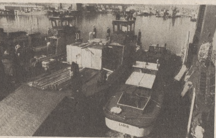
PHZ „Navimor” wspólnie z firmą holenderską realizuje kontrakt na budowę stoczni remontowej w stolicy Nigerii — Lagos. Droga morską transportowane będą: maszyny, dźwigi, promy, motorówki, holowniki i pontony.
