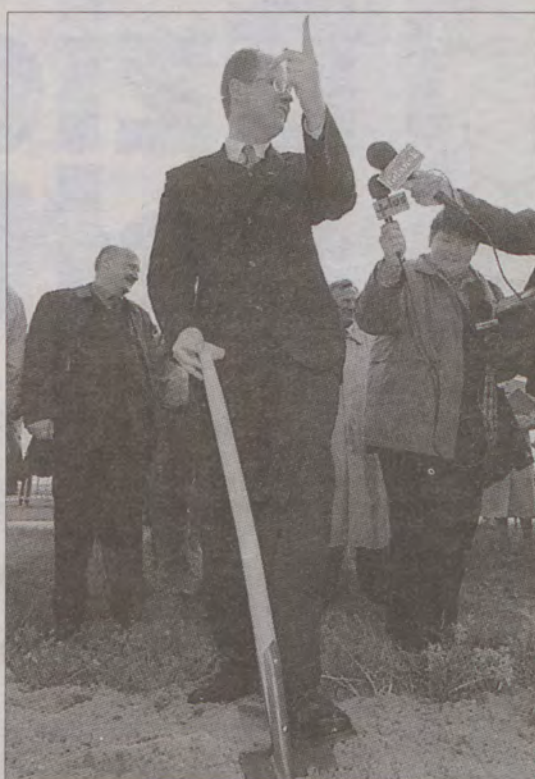
Pierwszy wykop pod nową trasę.
