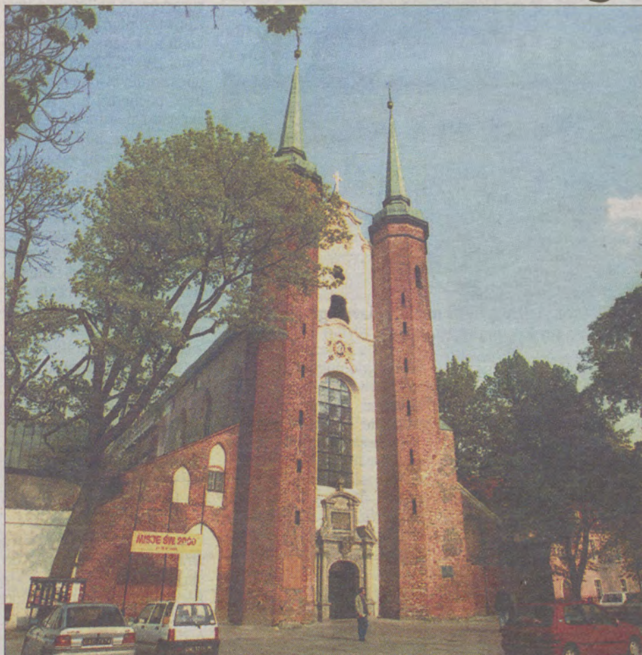
Reflektory wyeksponują niezauważalne często elementy katedry.
