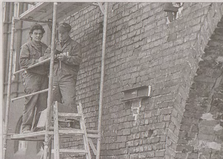
Nadwątłone, gotyckie mury gdańskiej Wieży Więziennej zabezpieczono stalowymi ściągam i kłami. Fot. Robert Kwiatk
