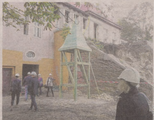
Na budynku dworca zostaną odtworzone detale, które zdołały go na początku XX wieku. Konstrukcja wieżyczki już gotowa
