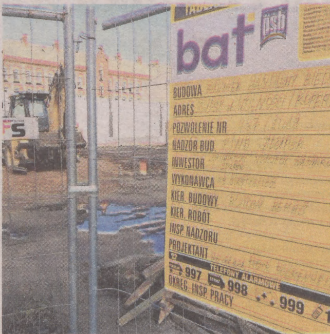
Nowy obiekt handlowy przy ul. Wolności powstaje w sąsiedztwie stacji benzynowej Circle K
