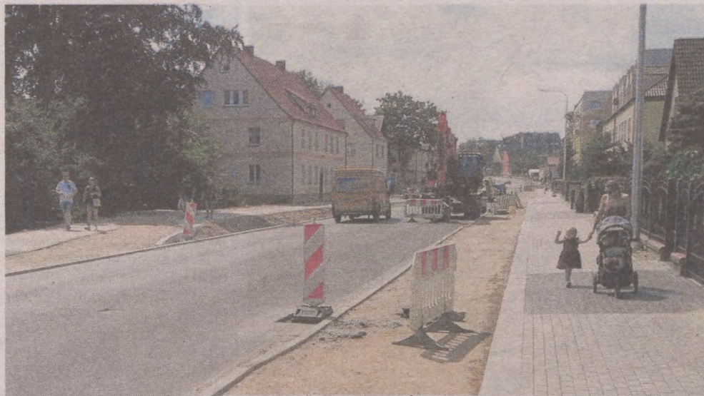
Przystanek dla pasażerów jadących w stronę Słupska zmienia dotychczasową lokalizację. Jest budowany tuż przed mostem (na zdjęciu zatoka po lewej), ok. 200 metrów dalej od obecnego
