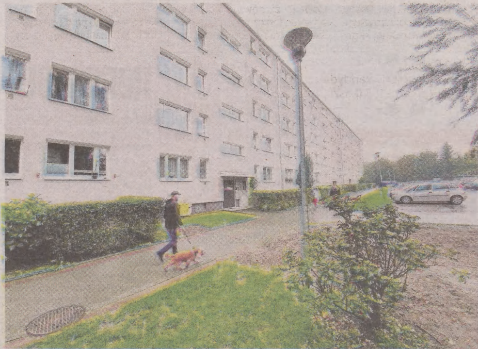
Od marca mieszkańcy ul. Piłsudskiego 7 nie mają oświetlenia od strony podwórka
