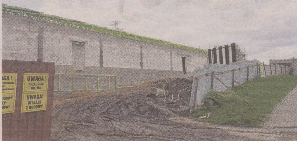
Praca na budowie nowej Biedronki przy ulicy Grunwaldzkiej w re. Inwestor zapowiada, że nowy sklep powinien być otwarty w marcu 2020 roku
