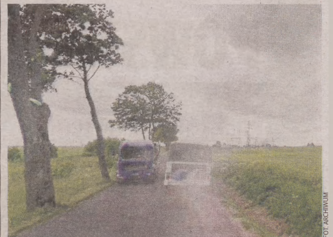
Dzięki dofinansowaniu z programu schetynówek w powiecie słupskim udało się już przebudować m.in. część drogi z Kobylnicy do Kępic
