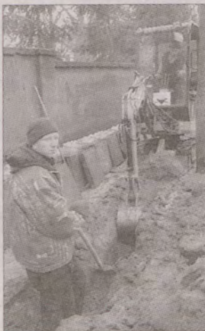
Przy ulicy Wojska Polskiego trwają prace budowlane. Postawione zostaną także latarnie.
