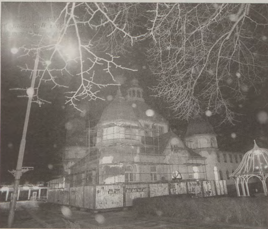
Wiosną zostaną zakończone prace przy elewacji Szpitala Reumatologicznego w Sopocie.
