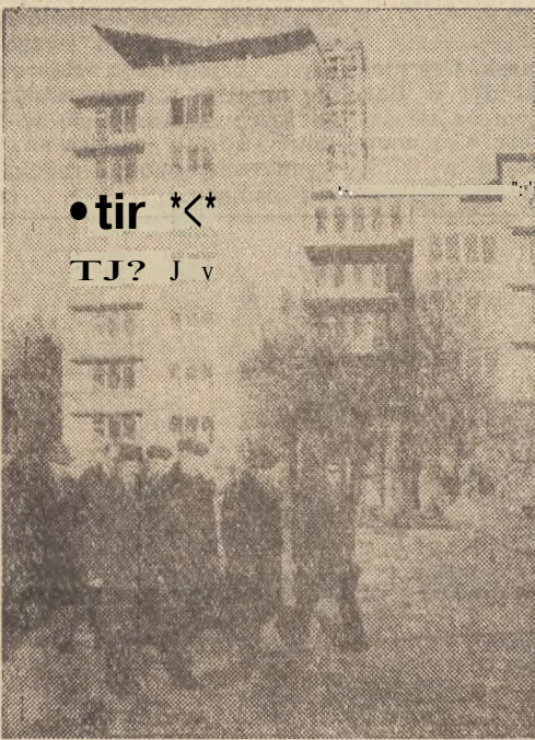
Na zdjęciu: wicepremier tow. Zenon Nowak. I sekretarz KW PZPR tow. Antoni Kuligowski i działacze kołobrzescy w czasie wznoszonego obecnie 7-kondygnacyjnego sanatorium budowanego przez Urząd Rady Ministrów.
