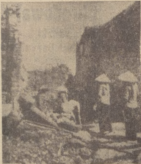
Ludność północnego miasta Dam Dinh, leżącego ok. 100 km od Hanoi, usuwa zniszczenia spowodowane pirackim na lotem amerykańskich bombowców.
