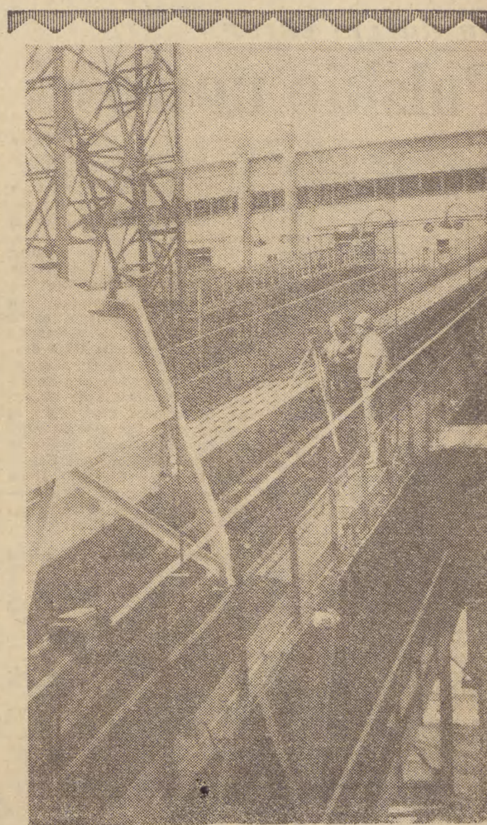
Wśród wielu nowych obiektów, które powstają w kombinacie hutniczym im. Lenina w Nowej Hucie, znajduje się również (będąca obecnie w trakcie rozruchu) spiekalnia rud — aglomerownia. Dzięki uruchomieniu aglomerowni, huta będzie mogła zwiększyć wydajność czterech wielkich pieców o około 600 ton surowki na dobę. Na zdjęciu fragment nowej aglomerowni tuż przed rozpoczęciem rozruchu. CAF — Gawliński
