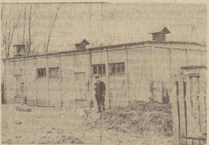
Z zewnątrz budynek nie prezentuje się najgorzej, lecz we wnętrzu przypomina zimną wilgotną studnię... Fot. J. Lesiak
