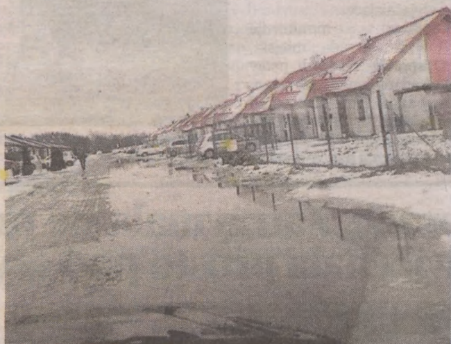
Osiedle nowych domków z zalewaniem ma problem od lat
