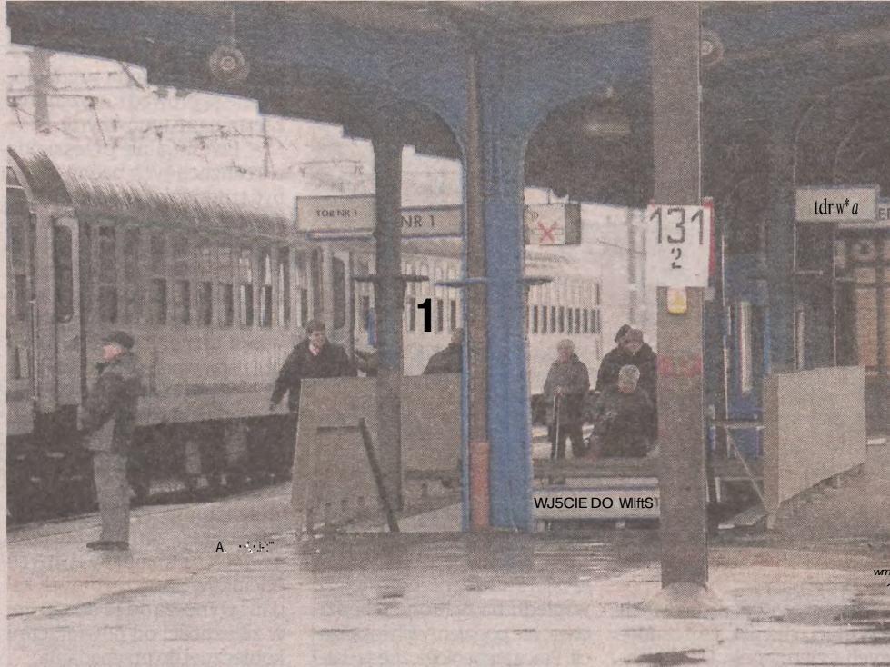
Budowa dworca, modernizacja linii kolejowej oraz budowa węzła transportowego to plany
