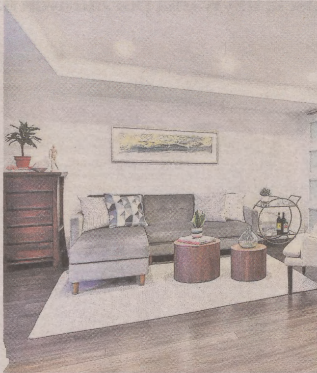
By uwolnić się od odgłosów sąsiadów, z góry można zamontować podwieszany sufit. Ledy dodadzą uroku
