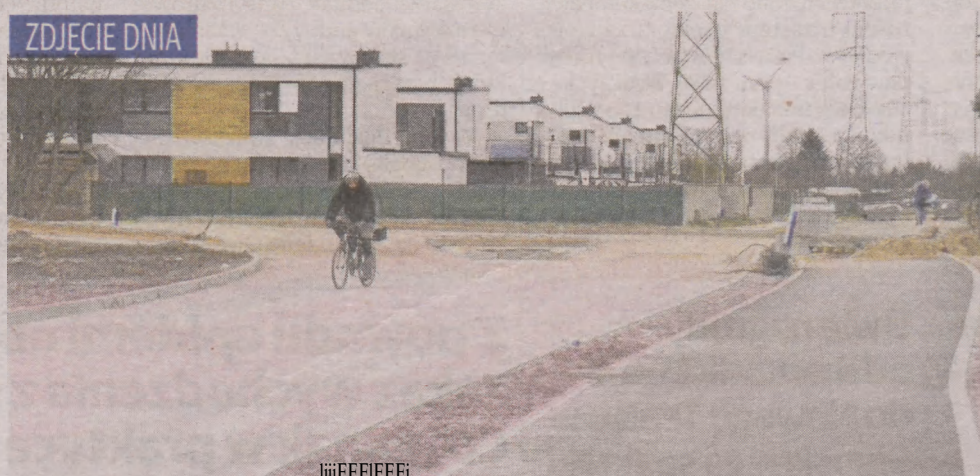
Prace budowlane na ulicy Legionów Polskich w Słupsku nabrały tempa. Wylano już przerwsze warstwy asfaltu, wyznaczone są miejsca parkingowe, gotowa jest ścieżka rowerowa, widoczne jest również rondo. Wkrótce modernizacją zostanie objęty odcinek ulicy Zaborowskiej, (olo)
