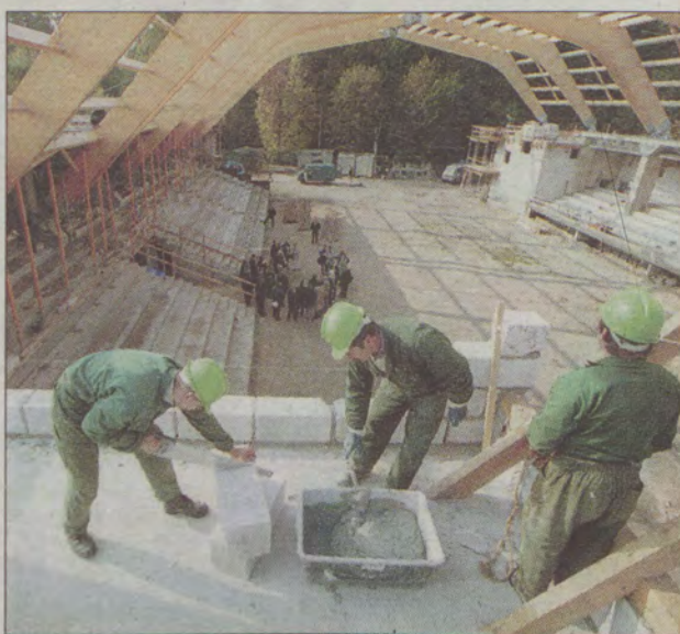
Hala sportowa w Sopocie ma być gotowa w kwietniu przyszłego roku.
