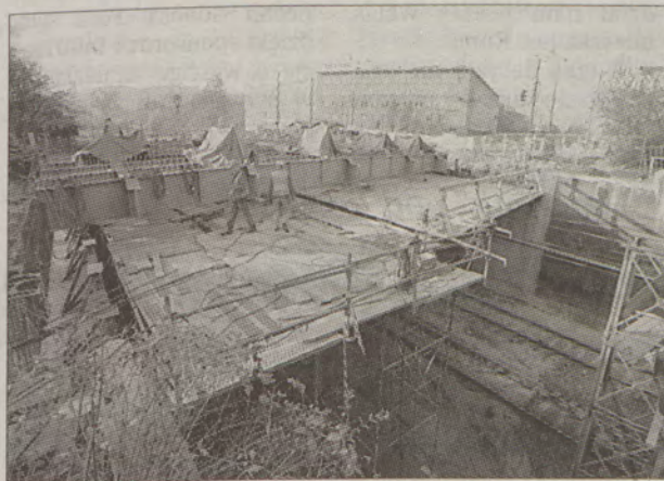
Remont wiaduktu na Hucisku rozpoczął się w połowie września. Od 15 listopada prawdopodobnie będą mogli z niego korzystać piesi.
