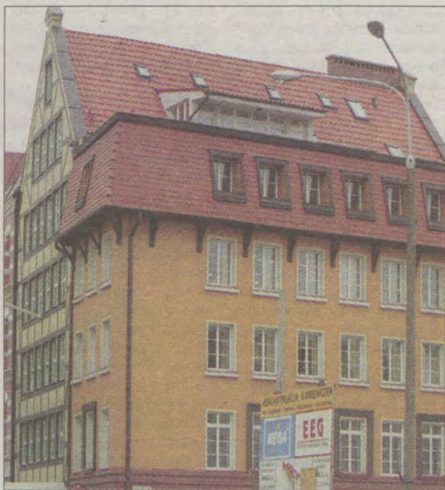
Na pierwszym planie - budynek przy ul. Chmielnej 101. Za nim widać „sporny”, wyższy dach kamienicy o numerze 102.
