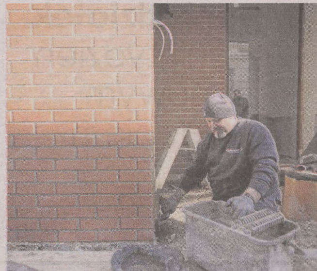
Na budowie praca wre
