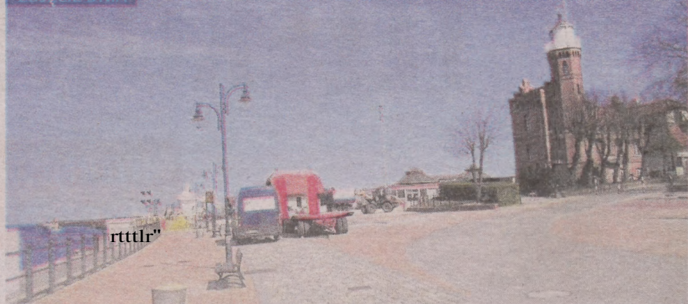
Zakończono remont promenady w pobliżu latarni morskiej w Ustce. Naprawa nawierzchni w odcinku pomiędzy Nabrzeżem Pilotowym a latarnią morską w porcie trwał kilka dni. Spacerowicze mogą swobodnie korzystać z deptaka.
