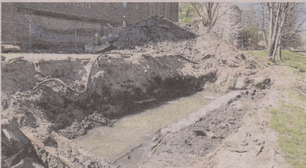
Przy Baszcie Czarownic dokopano się do drewnianych umocnień brzegu
