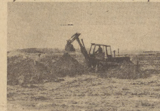
Koparka kopie dół pod stopy fundamentowe przyszłego magazynu. Fot. J. Piątkowski
