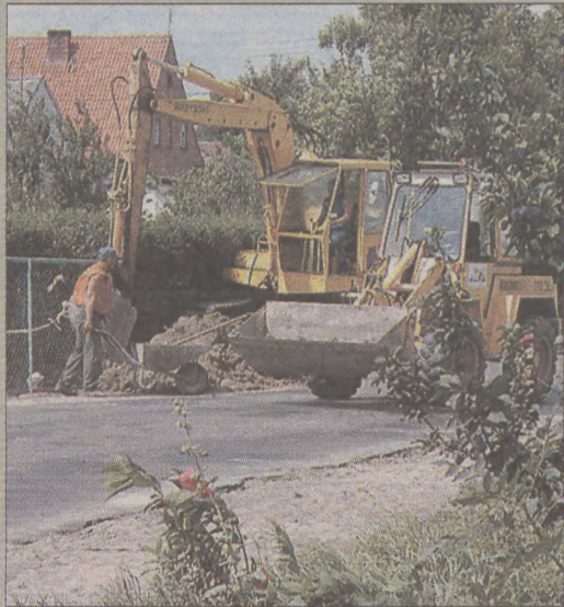
Budowa kanalizacji burzowej przy ul. Pięknego i Domańskiego dobiega już końca.
