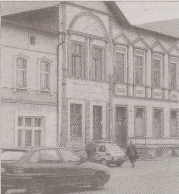
Fatalną wizytówką Przechlewa jest niszczący budynek w centrum miejscowości. Fot. Mariusz Rutkowski
