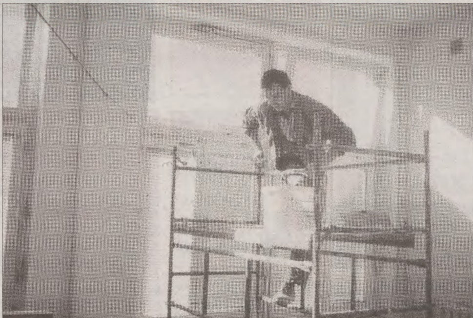
Wojciech Mionskowski z Kościerzyny podczas prac remontowych w siedzibie agencji.
