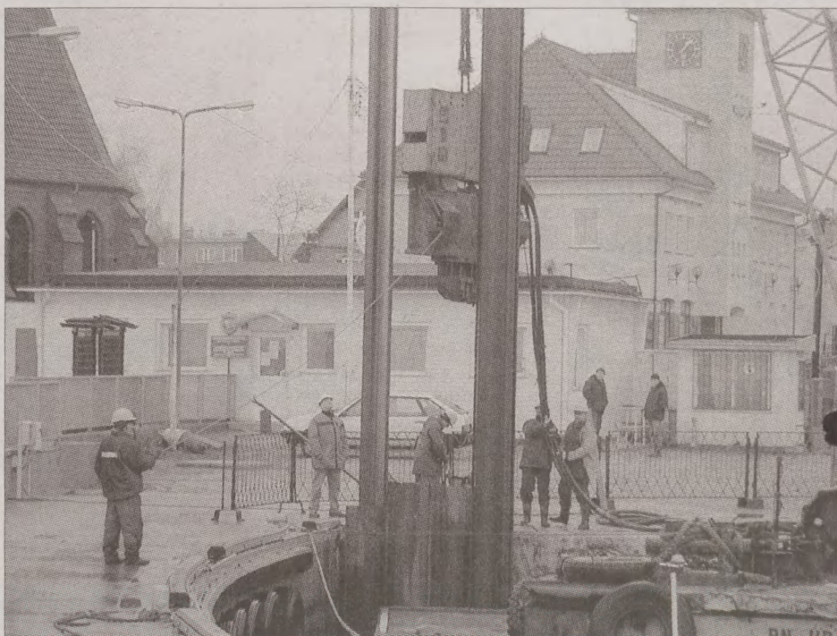
Ograniczeniom przewidywanym w projekcie ustawy podlega w Helu również rozbudowa i modernizacja infrastruktury portowej. Fot. Krzysztof Miśdziol
