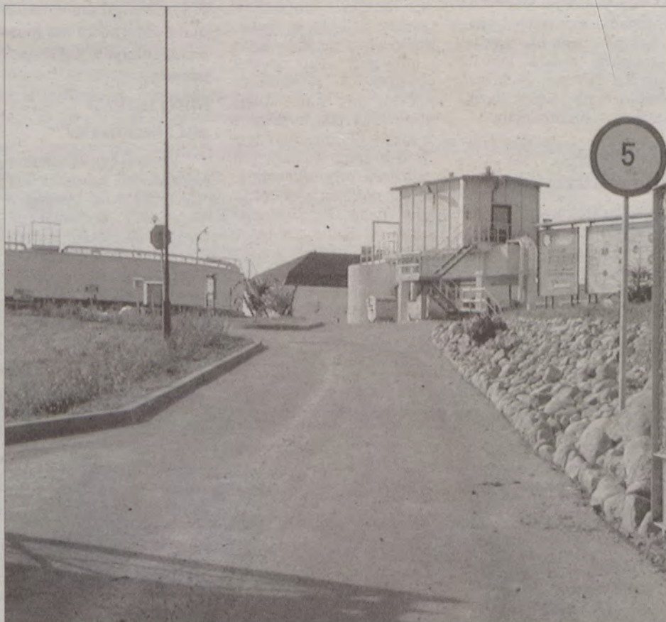
Modernizacja oczyszczalni to wspólna inwestycja miasta i gminy Człuchów.
