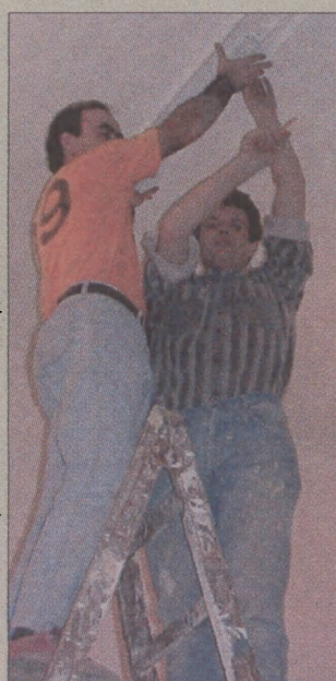
Podczas ostatnich prac remontowych w przyszłej władysławowskiej czytelnii.
