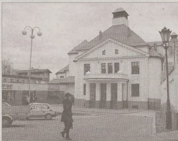
Przy modernizacji Hali Miejskiej Milenium zatrudnienie znalazło wiele tczewskich firm.
