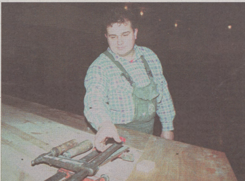
Kazimierz Grzegorzczak z tczewskiej firmy Budom pracuje przy budowie sceny w nowym budynku domu kultury.
