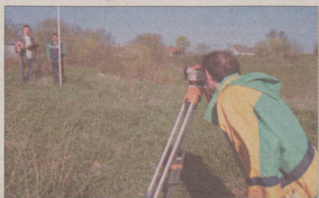
Geodeta Eugeniusz Cyron wytycza teren pod budowę oczyszczalni.
