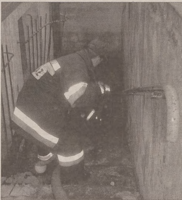
Strażacy pompowali wodę z piwnicy przez kilka godzin.
