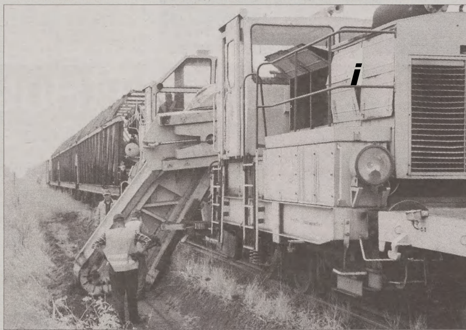
Na zakończenie remontu torowiska pomiędzy Darłowem i Sławem zabrakło 4 mln zł.
