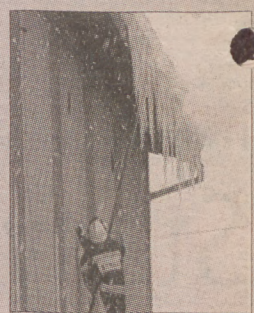
Niebezpieczne sople usuwa bytowska straż pożarna.
