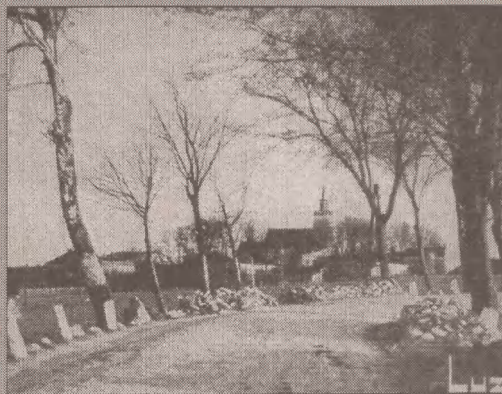
Droga wjazdowa do Luzina.
