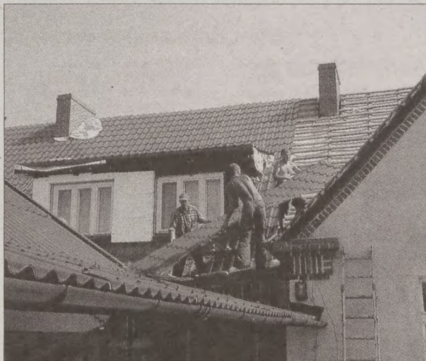
Stuletni dach w budynku szkoły podstawowej w Żukowie doczekał się kapitalnego remontu.
