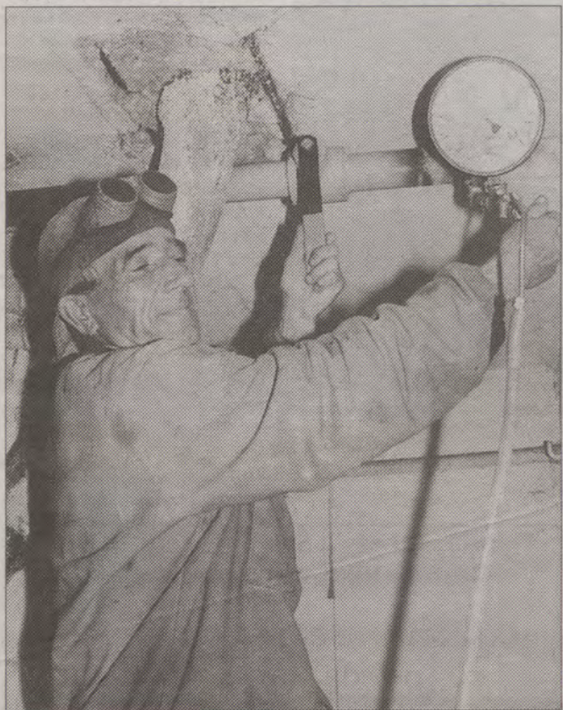
W kamienicy odcięto już gaz.
