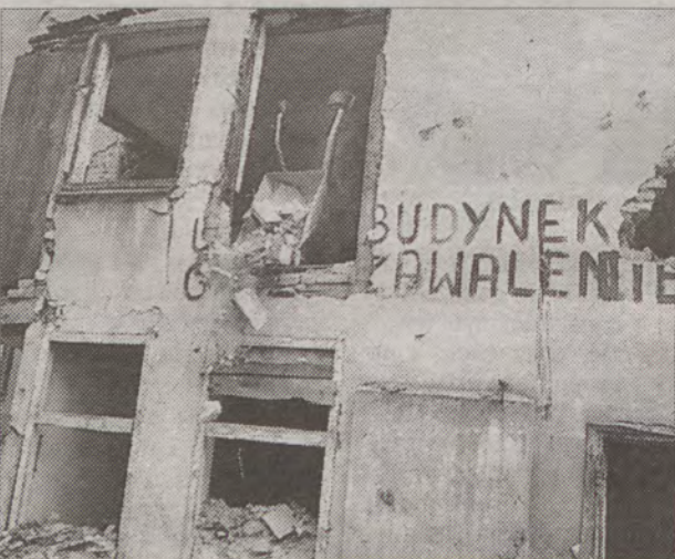
Ekipy budowlane wyburzają dwie historyczne kamieniczki przy ul. Sierociej nr 2 i 3 w Gdańsku.
