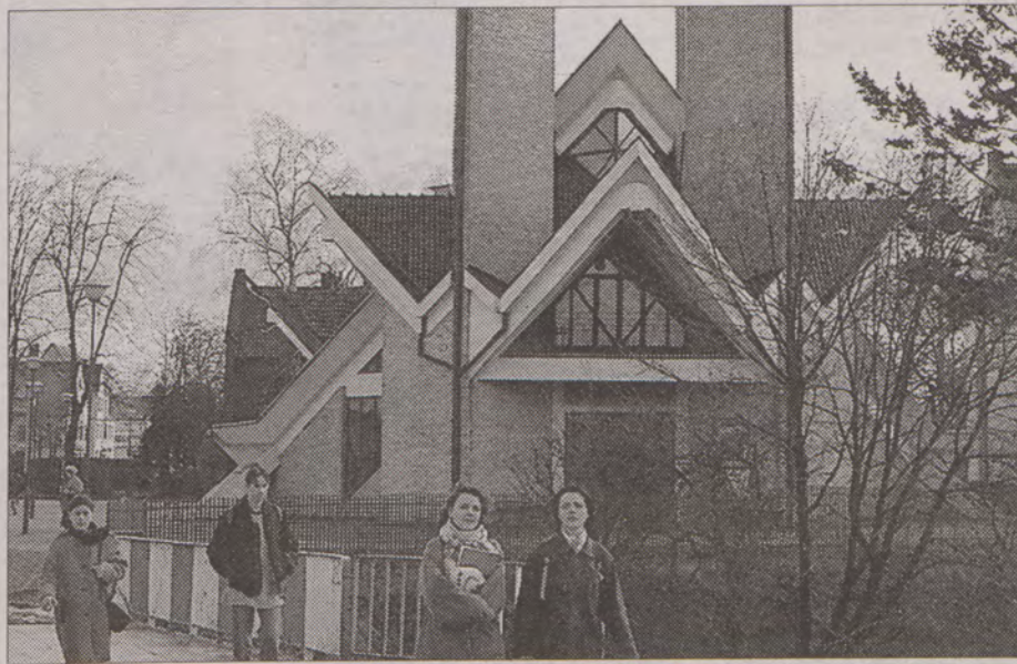
Kredyty zabezpieczano hipoteką na budynkach kościołów.
