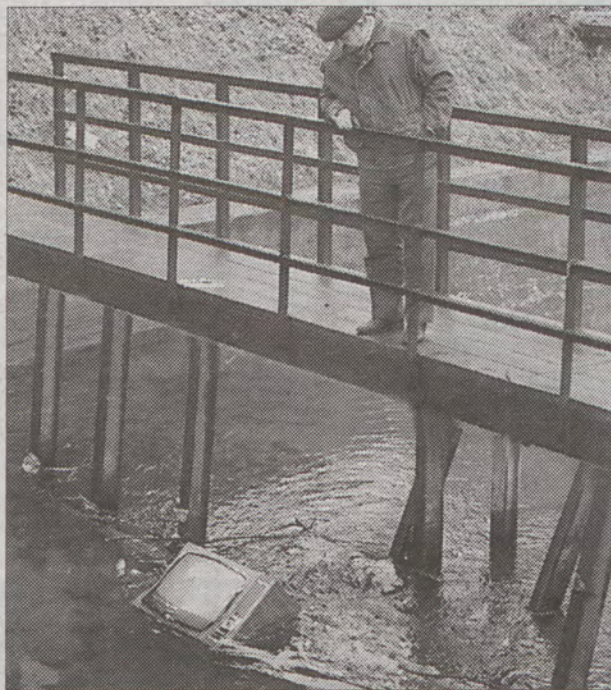
Po intensywnych opadach deszczu woda przybiera w kanałach i w piwnicach.
