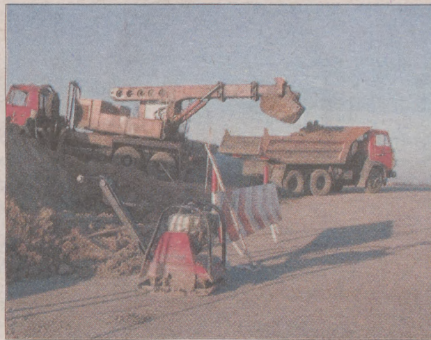
Niebawem ciężki sprzęt budowlany pojawi się też na drodze Zapceń-Stoltmany, gm. Lipnica.
