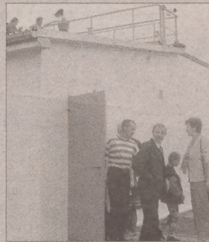
W Modrzejewie oddano do użytku nowoczesną oczyszczalnię ścieków.
