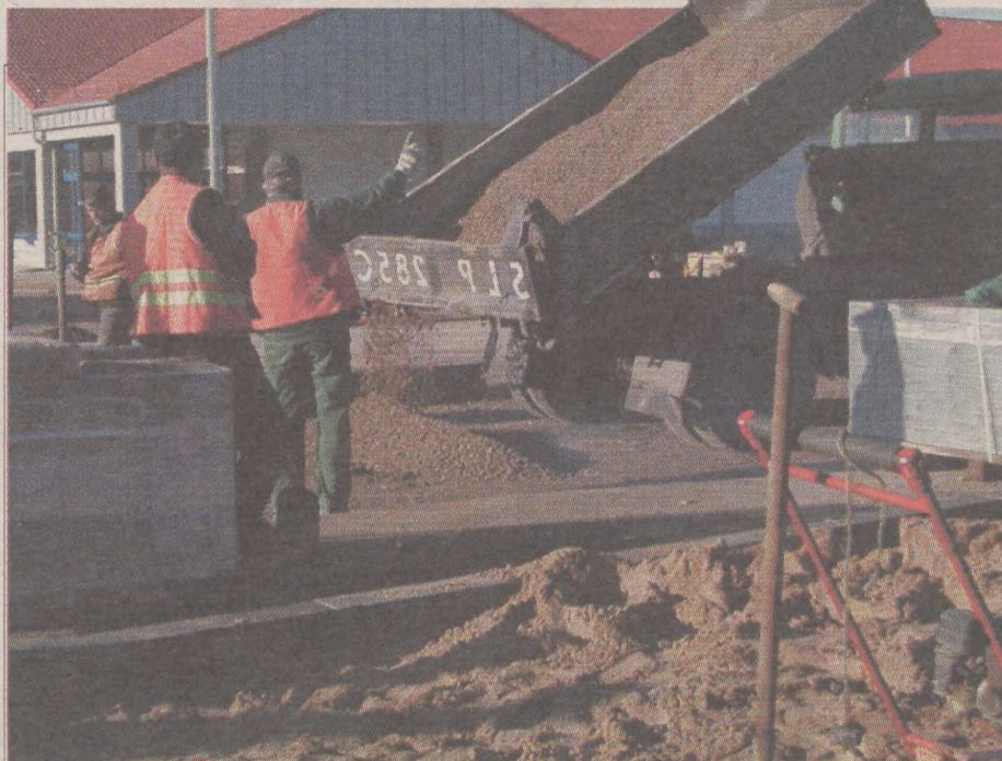
Teraz trwają już prace przy przebudowie ulicy Przemysłowej.
