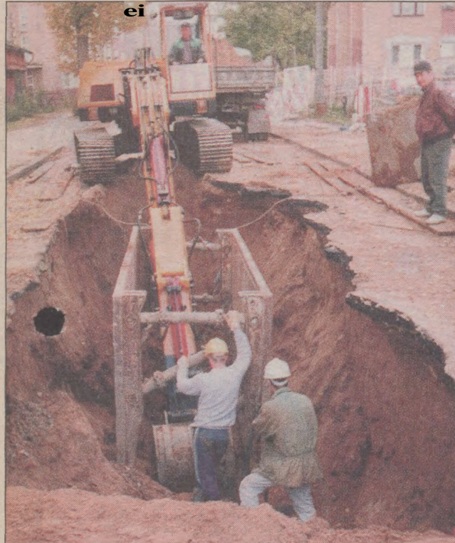
Przed wykonaniem modernizacji ulic w miarę możliwości uporządkowano kanalizację deszczową. Budowa kanału deszczowego przy ulicy 8 Marca.
