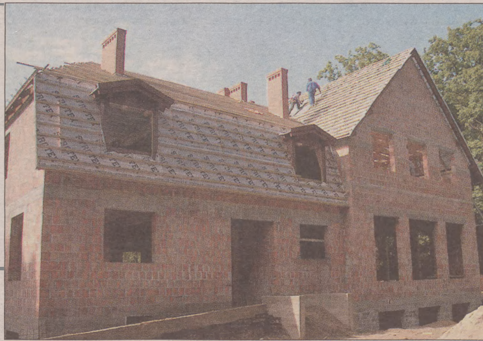
Jedno z najciekawszych miejsc w Kościerzynie, zwane popularnie Strzelnicą ożyje ponownie. Dzięki ogromnemu zaangażowaniu władz miejskich oraz Zrzeszenia Kaszubsko Pomorskiego pozyskano środki na odbudowę tego obiektu. Do końca tego roku powstający obiekt ma być doprowadzony do stanu surowego zamkniętego. Koszt pierwszego etapu wyniesie 900 tys. zł.
