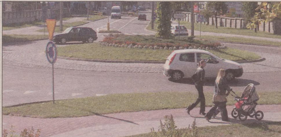
Miasto Kościerzyna uczestniczyło w programie poprawy bezpieczeństwa na drogach. Dzięki temu na drodze krajowej nr 20, a dokładnie na ul. Wojska Polskiego wybudowano dwa ronda, uruchomiono na tym odcinku dwa punkty sygnalizacji świetlnej, wybudowano nowy przepust do rzeki Bibrowa odbudowano także pas ruchu na ul. Wojska Polskiego i Drogowców. Obecnie trwa remont kolejnego odcinka drogi krajowej nr 20, który obejmuje wykonane trzecie rondo przy skrzyżowaniu dróg w kierunku Wdzydze Kiszewskie, Bytów.
