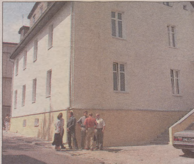
Jeszcze do niedawna budynek przy ulicy Dworcowej należał do obiektów, których „stan techniczny pozostawiał wiele do życzenia”. Dzięki przeprowadzonej inwestycji dom ten w chwili obecnej jest po kapitalnym remoncie i wygląda jak nowowytwarzany.
