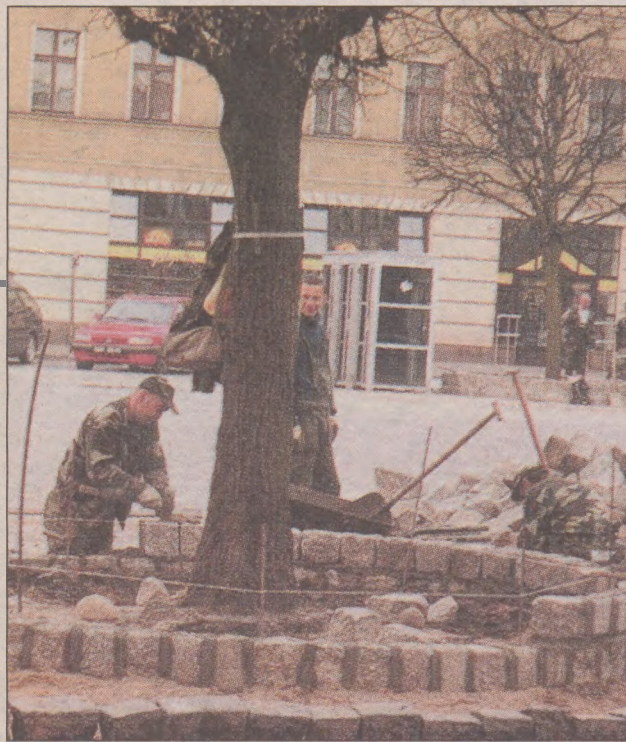
W centrum Kościerzyny, na Rynku ułożono kostkę granitową oraz wybudowano siedliska
