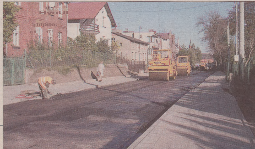
Wizerunek Kościerzyny zdecydowanie poprawiają odremontowane ulice. W ciągu czterech lat przebudowano oraz zmodernizowano w naszym mieście około kilkadziesiąt kilometrów ulic. Jednymi z największych inwestycji drogowych kompleksowa modernizacja ulicy 8 Marca.
