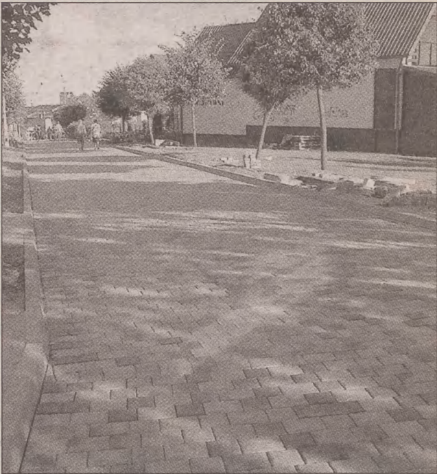
Dobiegają końca prace związane z modernizacją kościerskiego deptaku.
