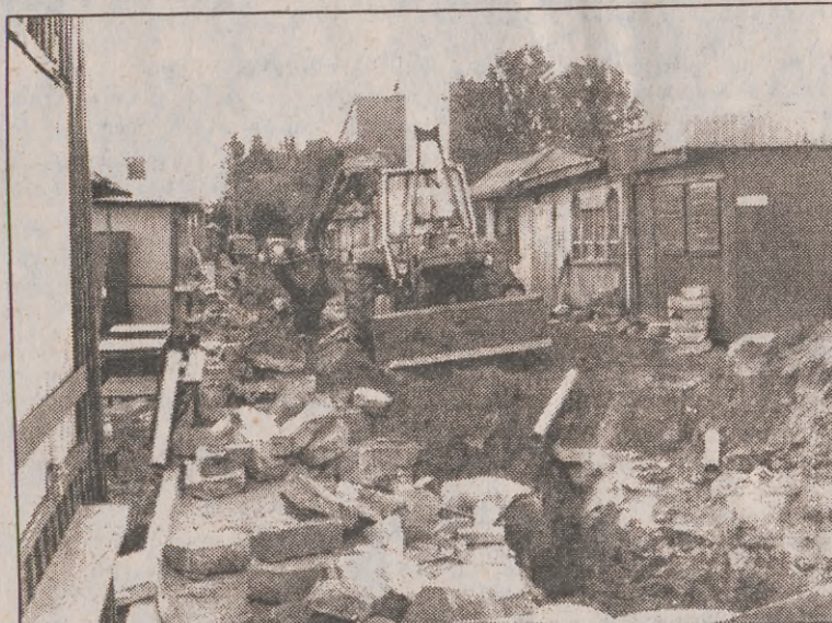
Na targowisku przy ul. Banacha w Słupsku wielkie wykopki. Wszystkie budki muszą być skanalizowane, posiadać wewnątrz bieżącą wodę. Kramy spożywcze i nabiatalowe są niezbędne, aż do zakończenia robót. Prace ziemne wykonywane są nawet w niedziele. Szkoda, że na skanalizowanie rynku zdecydowano się tak późno. (a)
