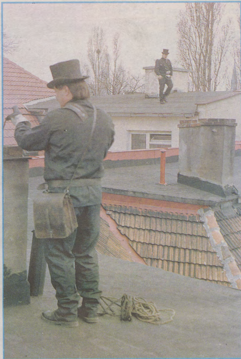
Tradycyjny ekwipunek kominiarza waży ponad dziesięć kilogramów. Główne obciążenie stanowi żelazna kula, którą opuszcza się do przewodu kominowego.
